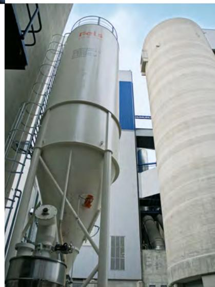
Silo-Dosieranlage für die Rauchgas-Reinigung.
