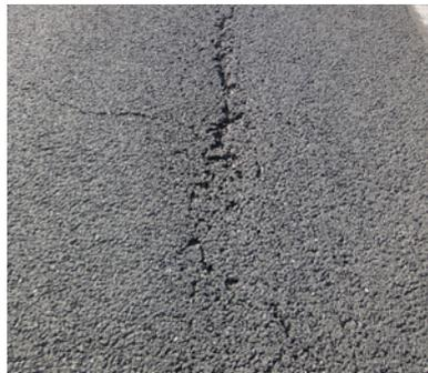
Hohe Verkehrsbelastung und Spannungen durch Temperaturschwankungen führen zu Rissbildungen. Kalkhydrat hemmt die Alterung des Mörtels, die Viskositäts-Zunahme wird reduziert und die oxidative Versprödung verringert.
