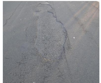
Haftverlust und Ausbrüche durch Feuchtigkeit führen zur Ablösung der Fahrbahndecke. Kalkhydrat erhöht die Adhäsion und Zugfestigkeit des Asphalts - insbesondere auch bei haftkritischen Gesteinen.
