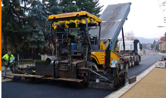
Bei Asphalten aus haftkritischem Gestein lassen sich durch den Einsatz von Fels Weißkalkhydrat und Normalbitumen vergleichbare Eigenschaften wie mit PmB als Bindemittel erreichen.
