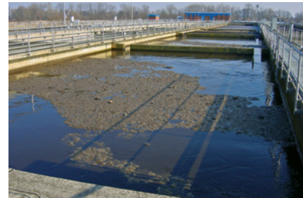
Schwimmschlamm tritt häufig bei starker Entwicklung fadenförmiger Mikroorganismen auf
