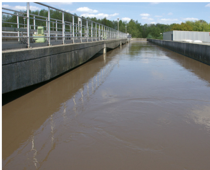
Unbelüftete Zonen tragen zur Kohlensäure-Akkumulation bei
