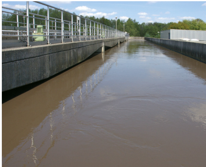
Unbelüftete Zonen tragen zur Kohlensäure-Akkumulation bei
