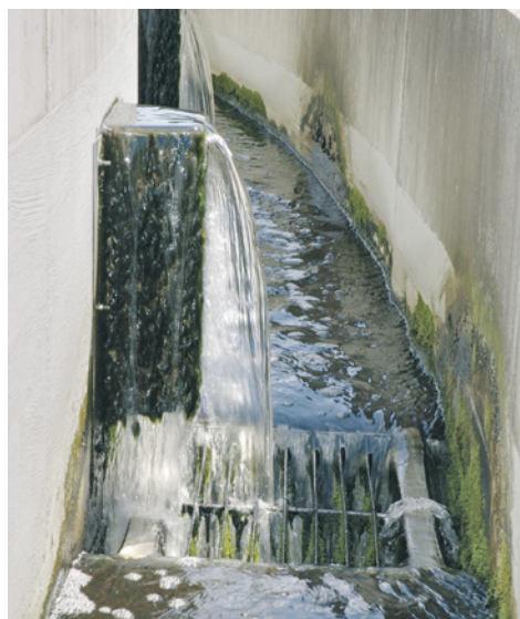
Abtrieb feiner Partikel mit dem Kläranlagen-Ablauf
