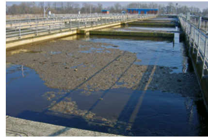
Schwimmschlamm tritt häufig bei starker Entwicklung fadenförmiger Mikroorganismen auf
